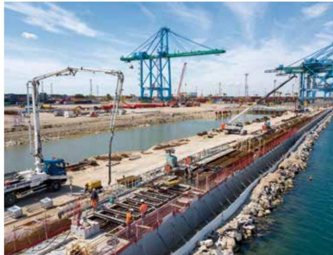
Il s'agit maintenant de mettre en œuvre la poutre de quai sur une longueur de 250 m. Cependant, les travaux sont menés sous pompage, car le niveau inférieur de la poutre est situé sous le niveau de la mer.
