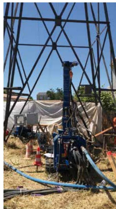
Pour ce qui est des travaux réalisés par SBFS, ces derniers sont réalisés sans coupure et sans enlèvement des pylônes existants : ce sont donc des foreuses de petite taille qui sont mises en œuvre pour des forages de diamètre 160 mm qui n'excèdent pas les 10 m.
