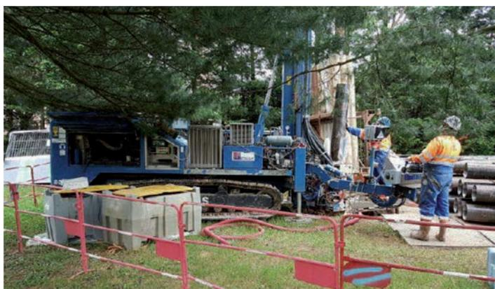
L'expérience acquise en géothermie et en rabattement permet de réaliser des forages jusqu'à 70 m de profondeur, avec la perspective d'une dizaine de forages par an sur des sites GRDF et GRTgaz.
